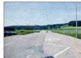
Gebiet Lieburg entlang der Usterstrasse
