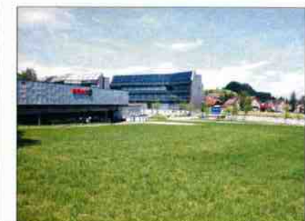
Im Vordergrund das Baufeld 5
